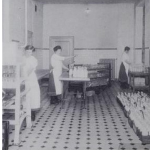
Flasketapperi fra 1914, betegnet som et "vældig" anlegg
